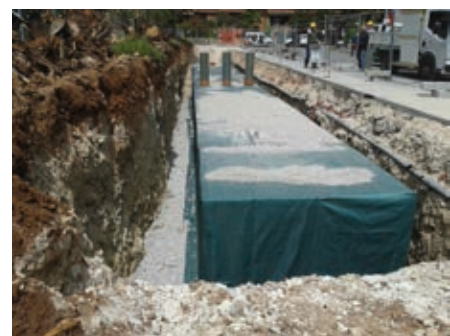
Figura 2 - Vasca di infiltrazione di via Amarilli in fase costruttiva
