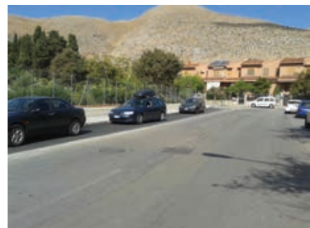
Figura 3 - Piazzale di via Amarilli con vasca sottostante costruita sotto il parcheggio
